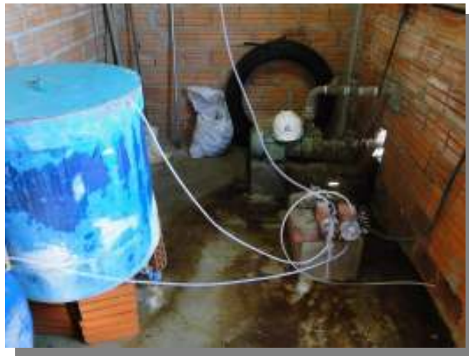
Figura 7: Casa de química. Fonte: Visita Técnica STE, 2010.
