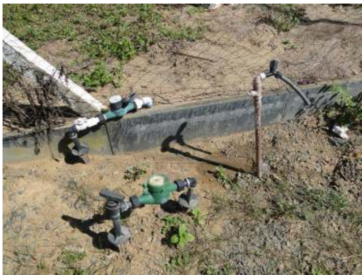
Figura 12: Micro-medidor. Fonte: Visita Técnica STE, 2010.
